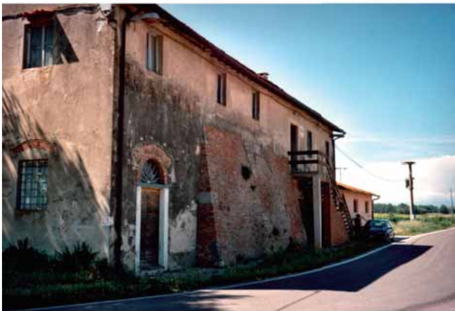
Fig. 13. La casa colonica della Torretta con le tracce della preesistente "Torre a Foce" cinquecentesca.
