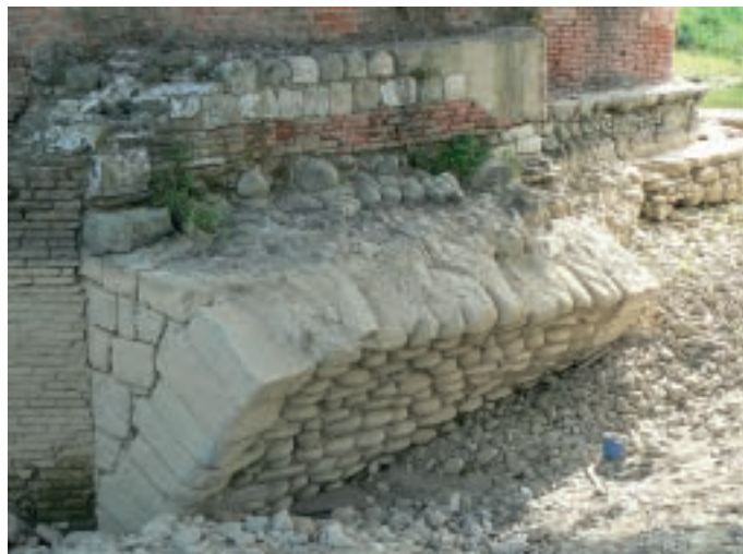
Resti dell'antico ponte in pietra sul torrente Ombrone, in località Pontelungo (Pistoia).
