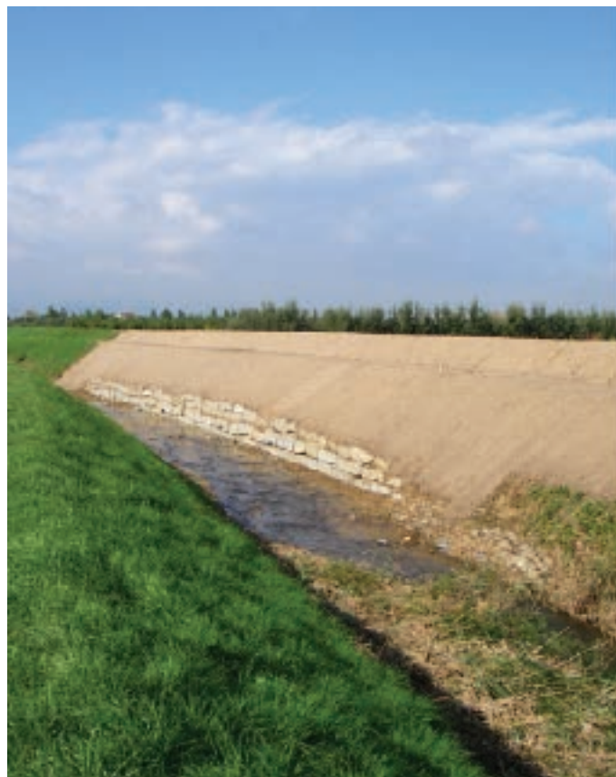
Interventi di sistemazione delle arginature del torrente Stella nel Comune di Quarrata (foto Consorzio di Bonifica Medio Valdarno).
