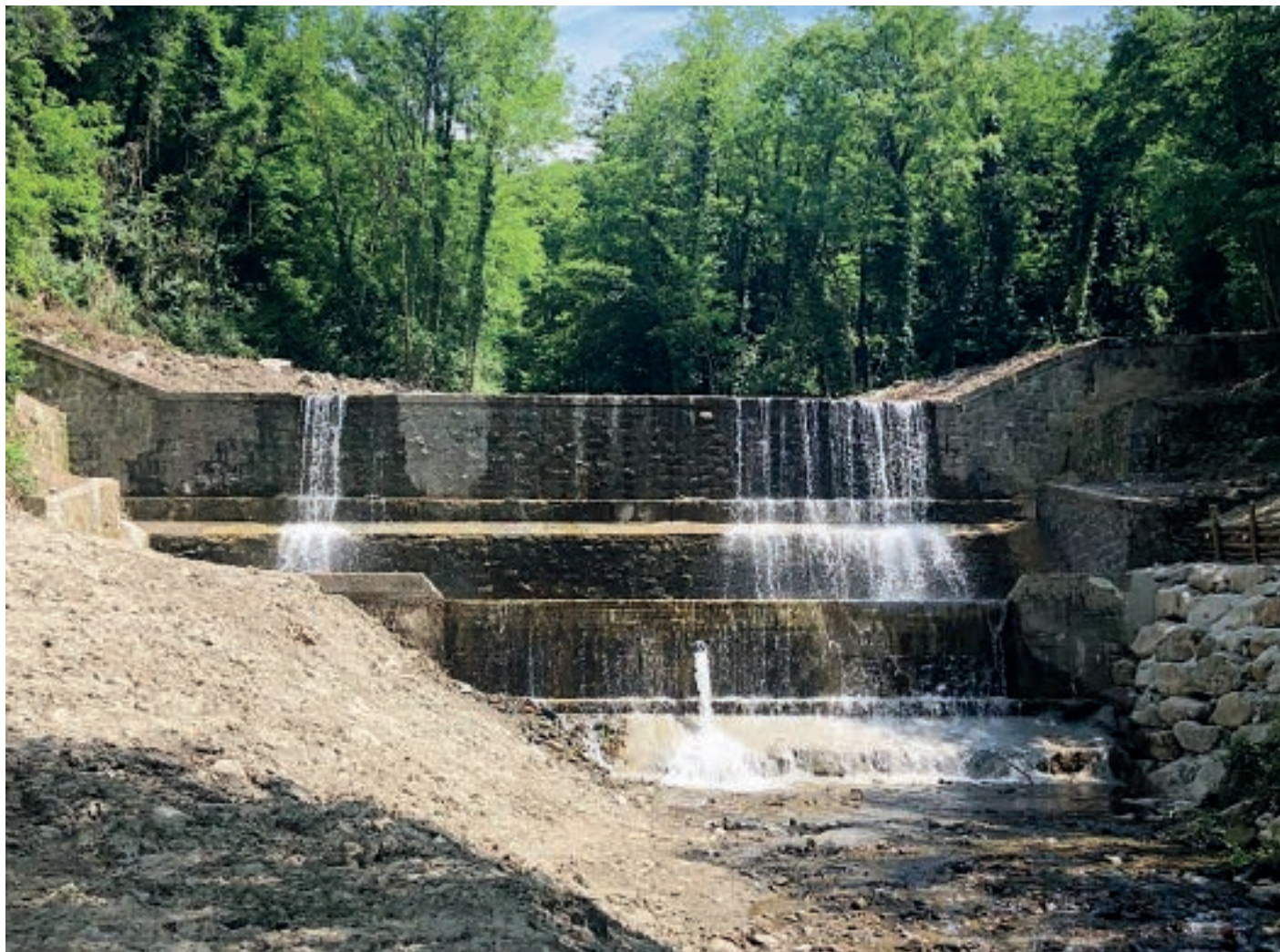
L'antica briglia sul corso dell'alto Ombrone in località Molino Bertocci, recentemente restaurata dal Consorzio di Bonifica 3 Medio Valdarno (fotografia Consorzio di Bonifica Medio Valdarno).
