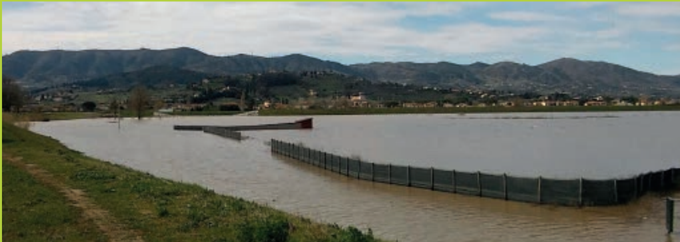
La cassa di espansione della Querciola con acque invasate (Fotografia Consorzio di Bonifica Medio Valdarno).
