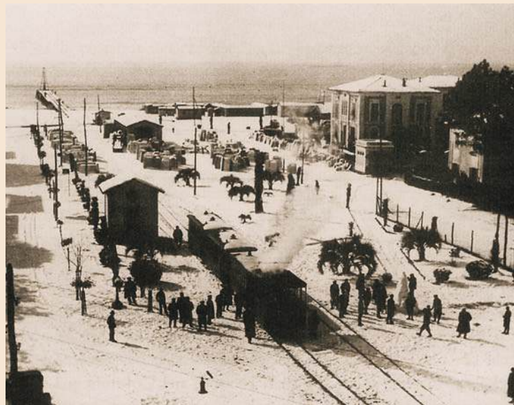
1929, il piazzale del pontile dopo una eccezionale nevicata
